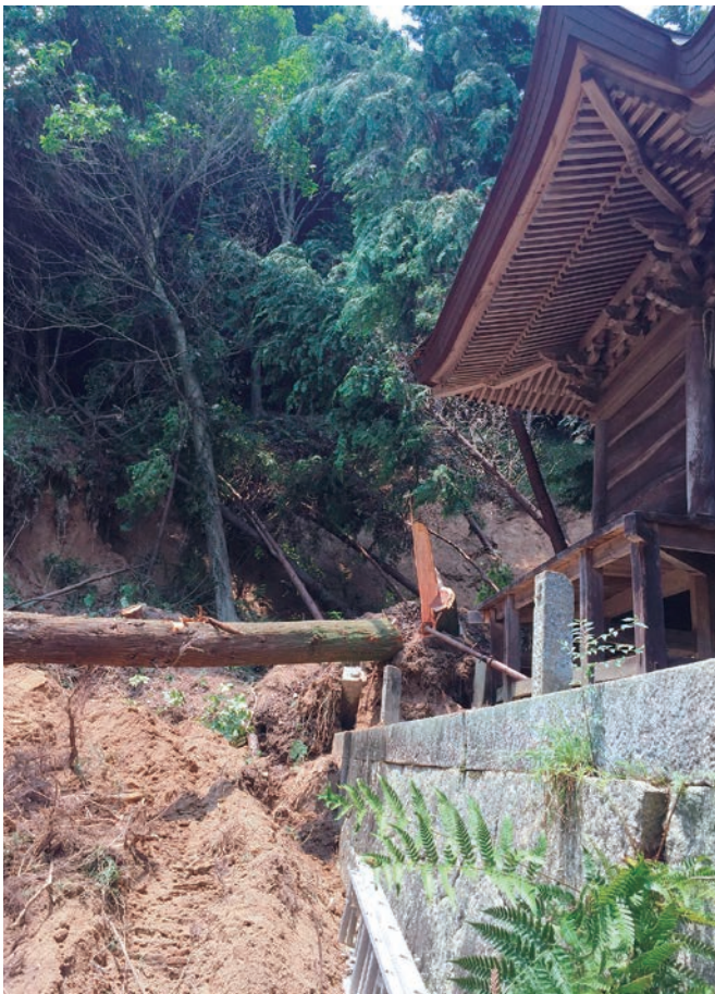
本殿側面に土砂流入 (武苔神社)
