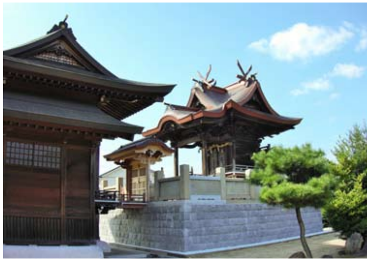
第 2 期工事で改修を終えた本殿と新設された平唐門
