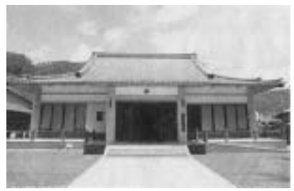
完成した「お祭り会館」
