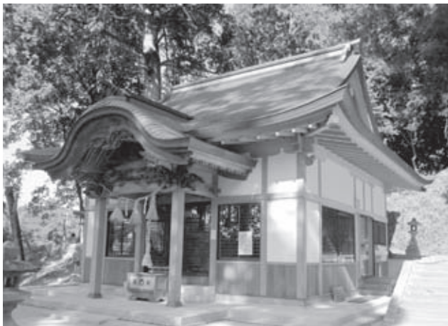
完成した社殿外観
