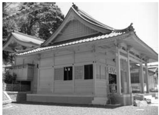
できるので、まことに神々しさを演出した構えである。銅板葺きの幣殿は二間四方で本殿までの階段と連続する覆い屋になっている。寒冷地ゆえの防寒対策と、本殿正面に取り付けの虹梁や化粧彫り、突き出した拳鼻の風化を防ぐ。
